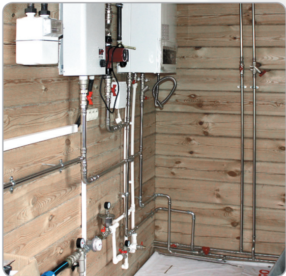
Подключение электрического и газового котла
