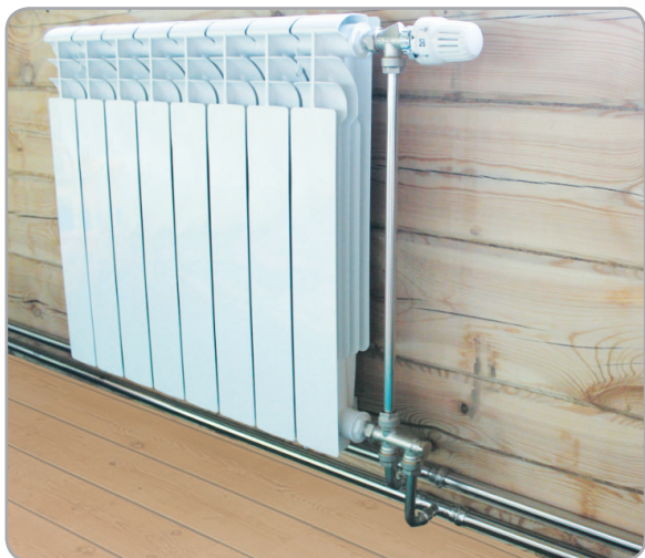
Узел подключения радиатора
